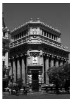
Fachada de la nueva sede central del Instituto Cervantes. Fotografía de Adrián Vázquez.
