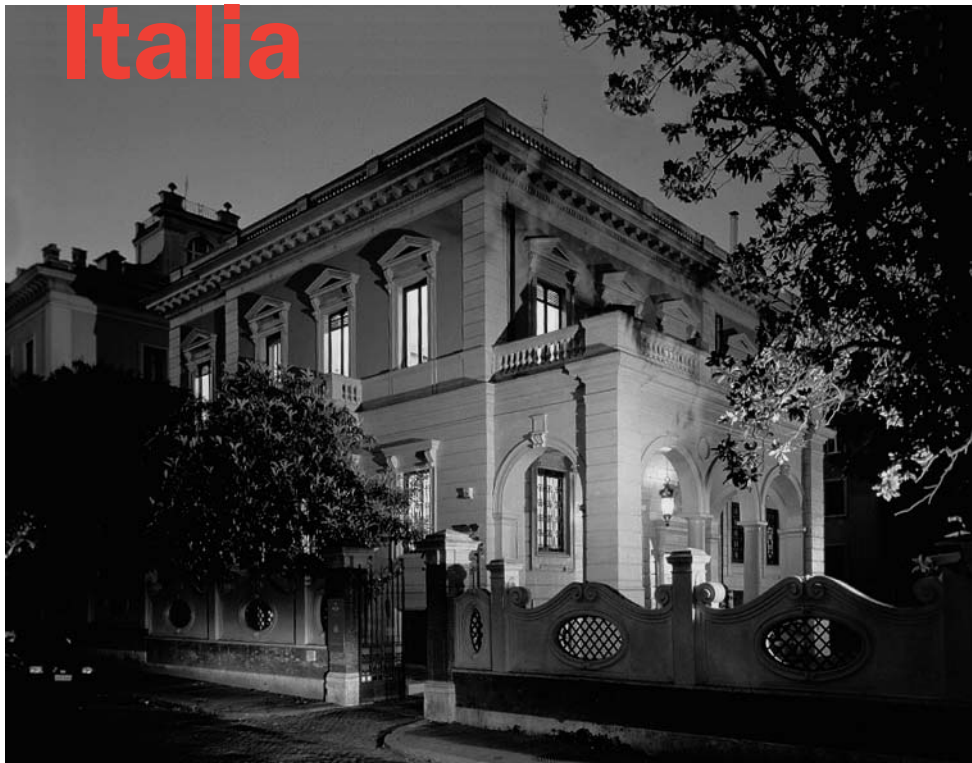
Fachada de la sede del Instituto Cervantes de Roma.
